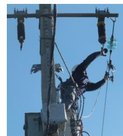
Photo LPO Rhône-Alpes : Equipe TST de ERDF intervenant sur un poteau à St Remèze pour la protection de l'Aigle de Bonelli
