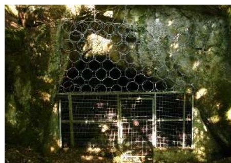
En décembre 2012, un filet pare-blocs a été placé afin d'améliorer la protection.
