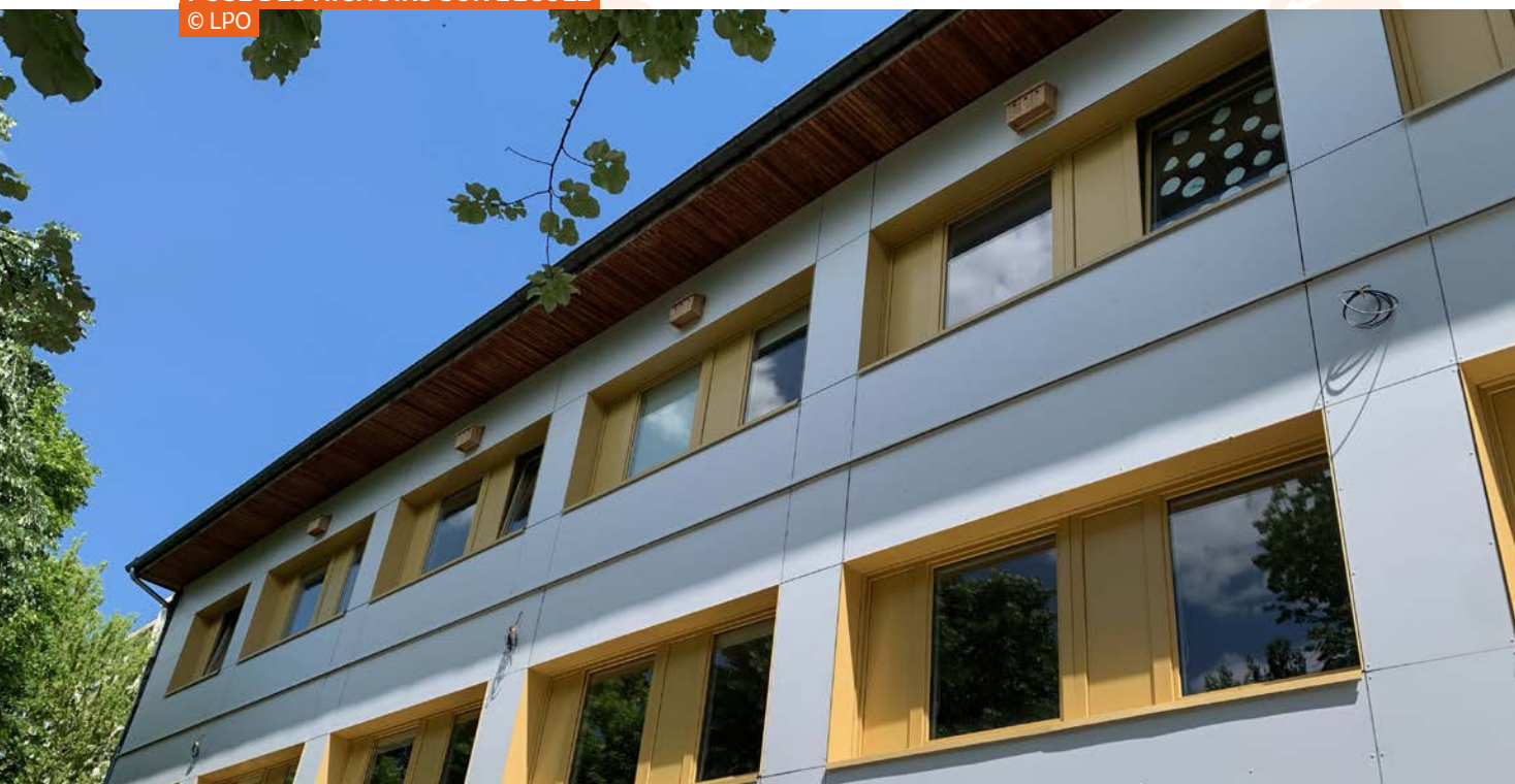
POSE DES NICHOTIRS SUR L'ÉCOLE © LPO
