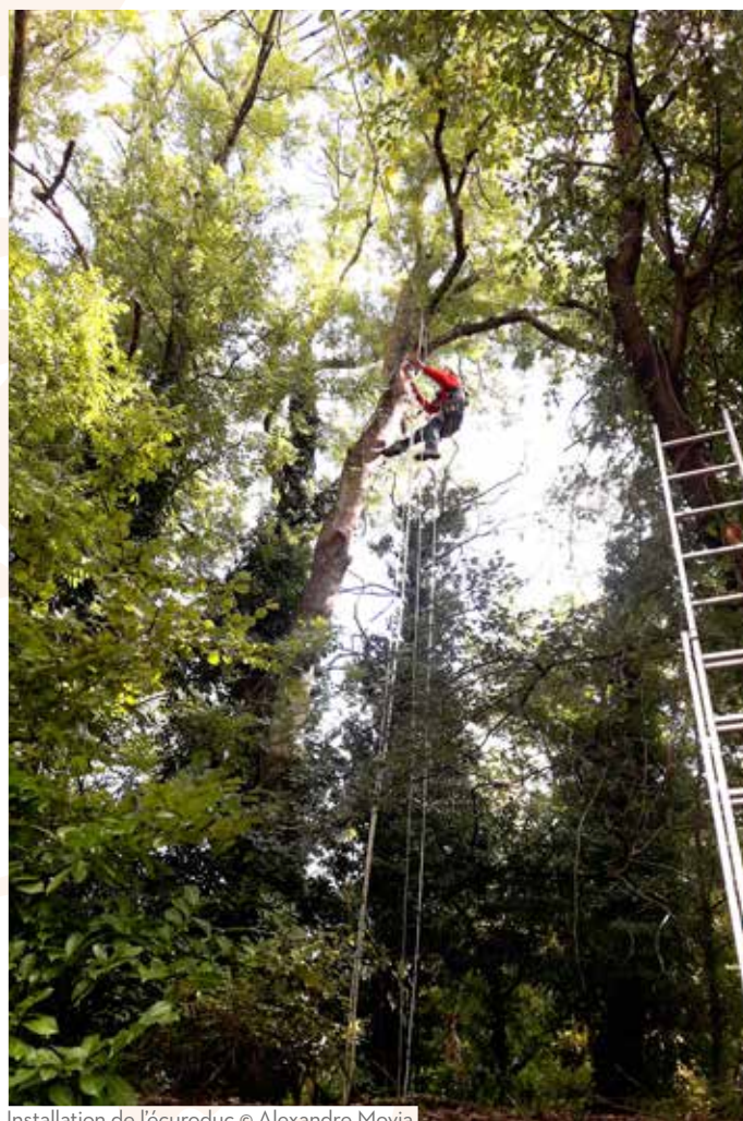
Installation de l'écuroduc © Alexandre Movia
