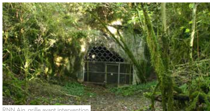
RNN Ain, grille avant intervention
