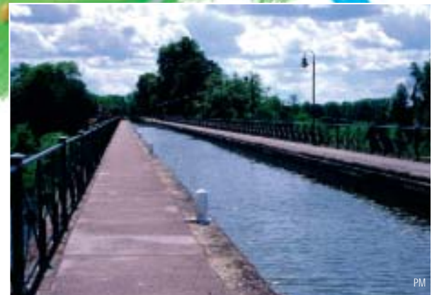
Pont canal de Digoin (71)
