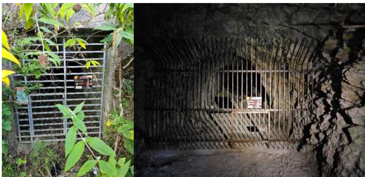
Figure 45 : Grilles de protection des carrières inférieure et supérieure
