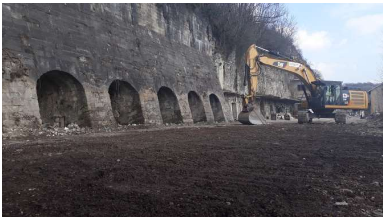
Figure 46 : Opération de dépollution de la plateforme inférieure du site (déchets inertes).
