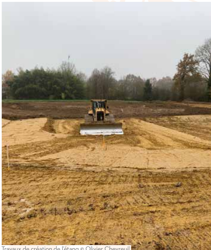
Travaux de création de l'étang © Olivier Chevreuil
