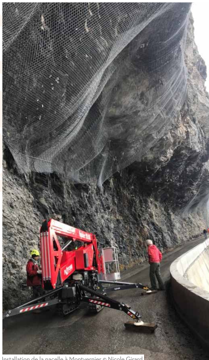
Installation de la nacelle à Montvernier © Nicole Girard
