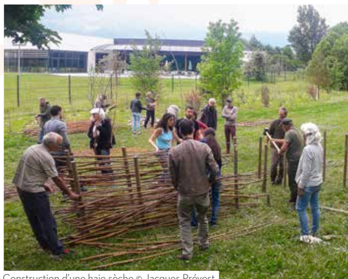
Construction d'une haie sèche © Jacques Prévost
