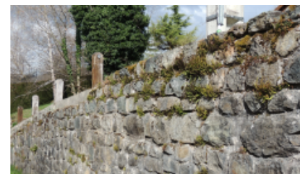
Muret de pierre, refuge pour la faune et la flore
