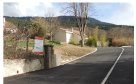
Accès imperméabilisé à une parcelle
