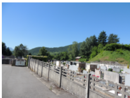
Cimetière aux abords imperméabilisés
