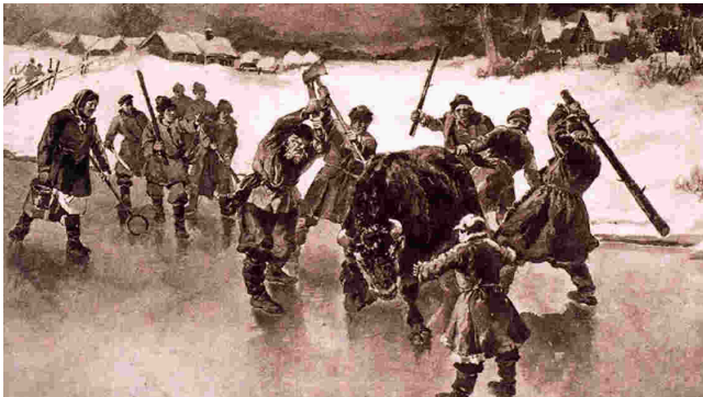
Figure 2 Une des causes d'extinction du Bison, la chasse
