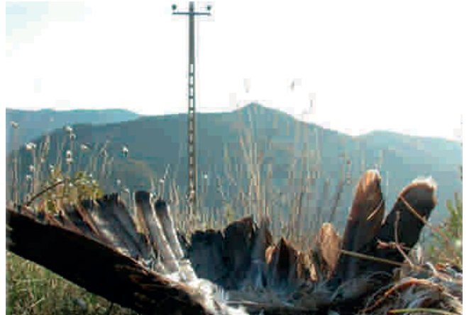
Figure 6 Dégâts d'une ligne électrique
